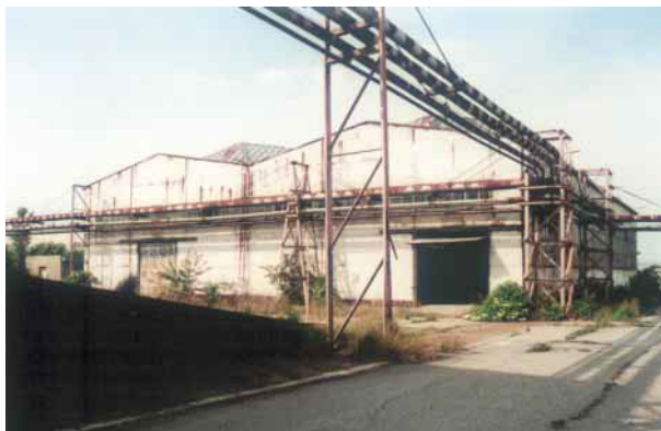
Hala č. 83 v havarijním technickém stavu
